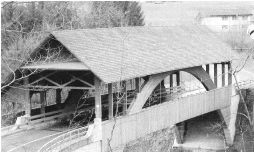
Lochermoosbrücke Ganterswil SG zugelassen 40 t, 1994. 2 Fahrbahnen + LV-Fahrbahn
