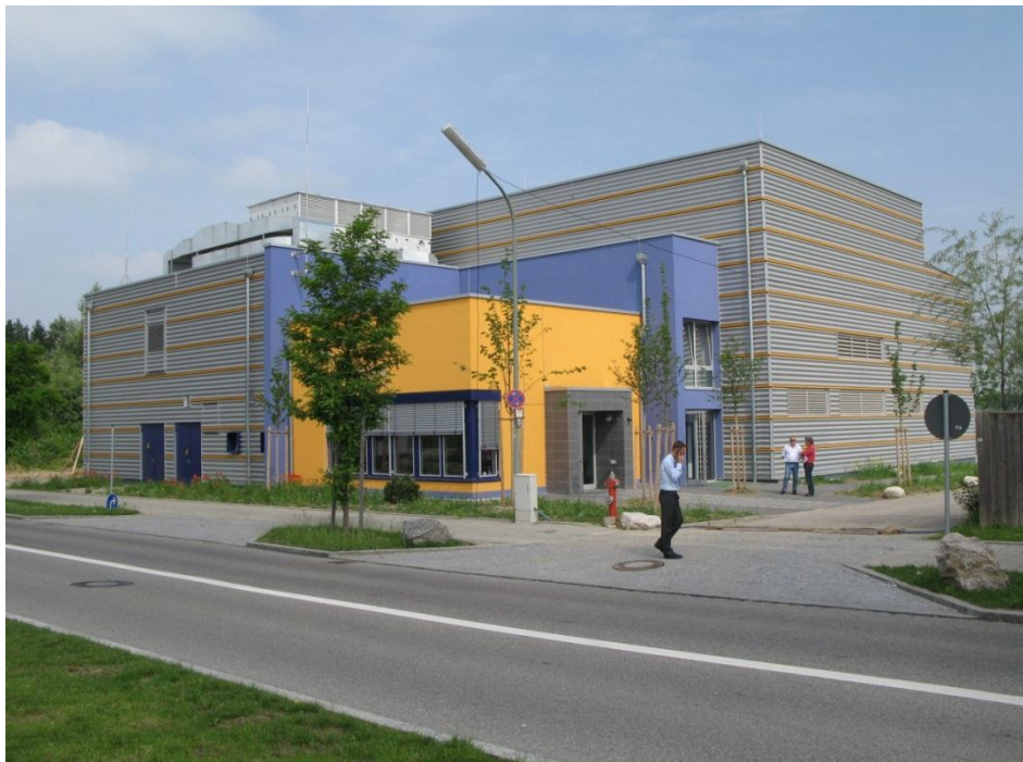
Figur 4: Geothermie-Kraftwerk Unterhaching, Südbayern. Am Rand eines Wohn- und Gewerbequartiers werden Strom und Wärme produziert.
