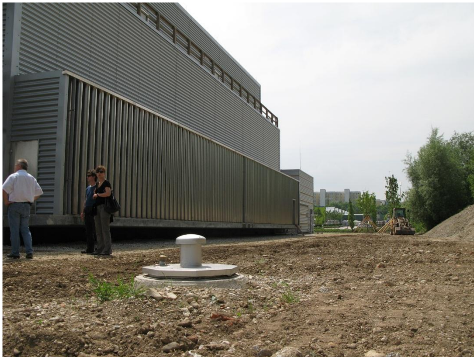
Figur 6: Kühlanlage des Geothermie-Kraftwerks Unterhaching, Südbayern. Blick auf die Westfassade. Im Vordergrund ein Grundwasserbrunnen für die Kühlwassergewinnung.
