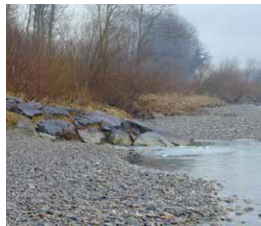
Zum Beispiel mit Hilfe von Buhnen wird die Erosion gestoppt.
