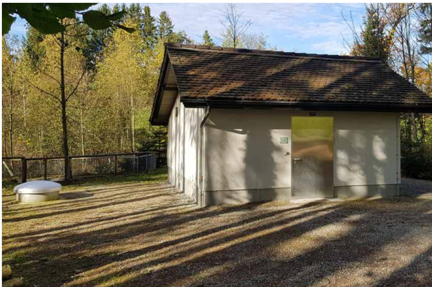
Grundwasserpumpwerk in Frauenfeld
